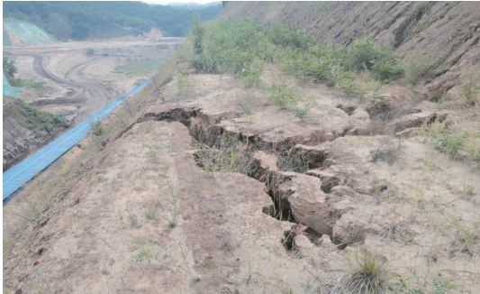
图 2 粉黄土高边坡坡面冲刷现象(镜向 224°)
